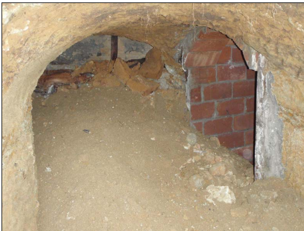
Foto 17: Cavitat a la paret nord de la galeria subterrània (Refugi 761) i col·lector principal del c/ Tapioles.
