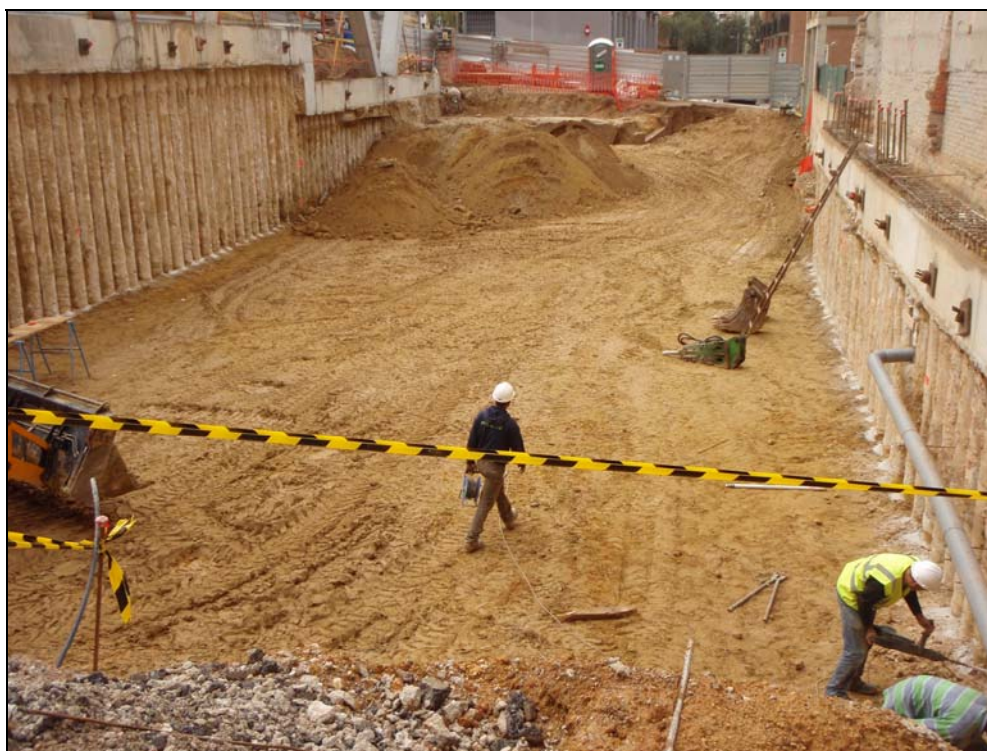
Foto 39: Rebaix definitiu del solar.
