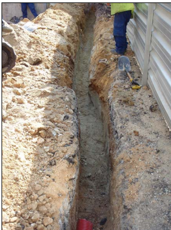
Foto 6: Rasa per la col·locació de cablejat elèctric.
