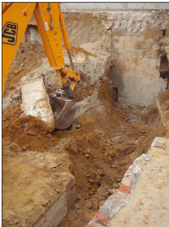
Foto 38: Desmuntatge de l'accés 1 i tàpia realitzada per l'obra (Refugi 761).
