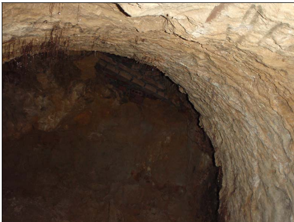
Foto 28: Volta de l'accés 3 o s'observen els totxos de l'escala de l'accés 1 (Refugi 387).
