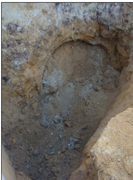
Foto 14: Treballs de neteja de la galeria subterrània (Refugi 761).
