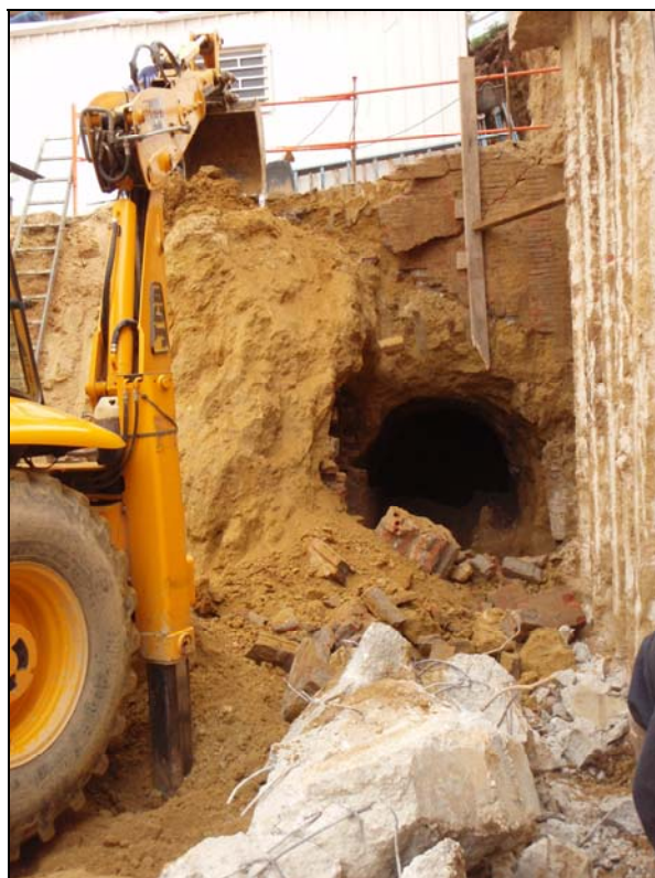
Foto 35: Desmuntatge de l'accés 2 (Refugi 387).
