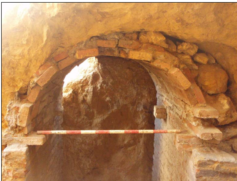
Foto 34: Volta de maó de pla de la galeria (Refugi 387).
