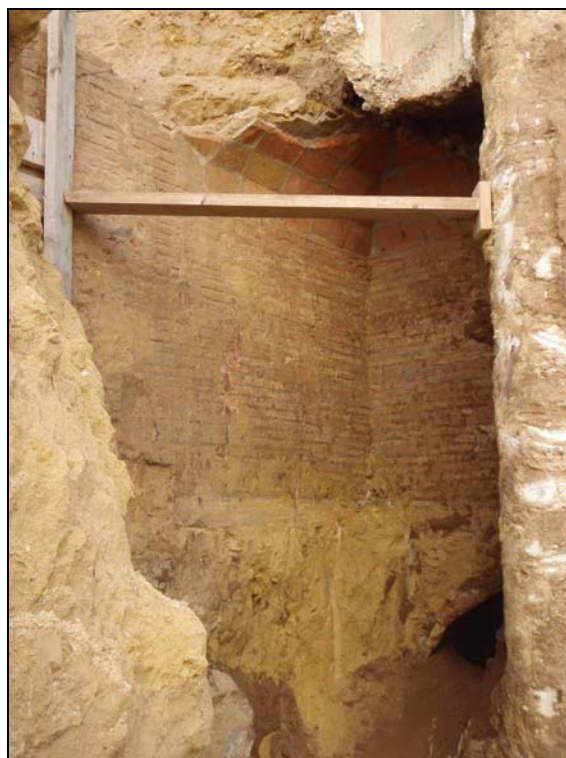
Foto 27: Paret est de l'accés 2 i coberta de la galeria d'entrada al refugi 387.
