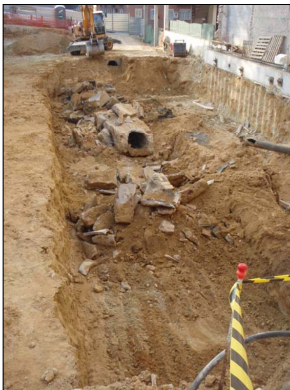
Foto 5: Desmuntatge del col·lector del c/ Anníbal.
