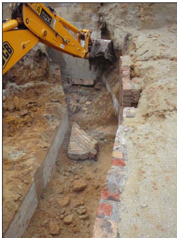
Foto 37: Desmuntatge de l'accés 1 (Refugi 761).
